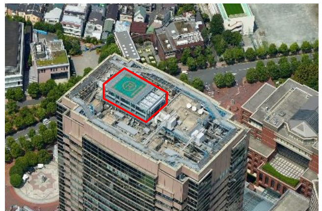
制震工事後の屋上の様子
